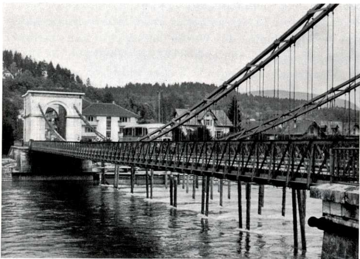
Die ersten Pfähle für die Notbrücke sind eingeschlagen
