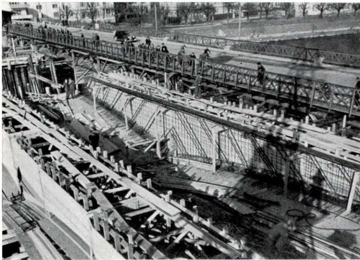
Schalen und Armieren der einzelnen Längsträger der Brücke
